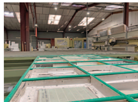
Centre de soudeuse-ébavureuse 4 têtes de l'atelier de production de menuiseries PVC.
